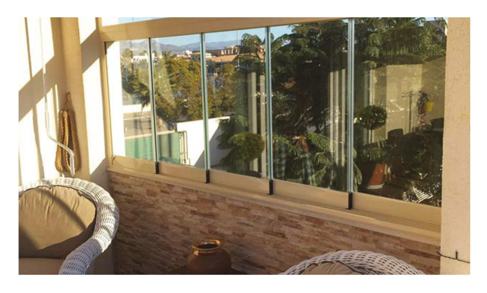
In fase di apertura per trascinamento, le ante si dispongono su un unico lato, sovrapponendosi le une alle altre e occupando l'ingombro di un singolo vetro.
