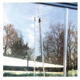
**Doppio tirante (interno ed esterno)** Ideale per l'apertura delle vetrate dove abbiamo la necessità di entrare anche dall'esterno
